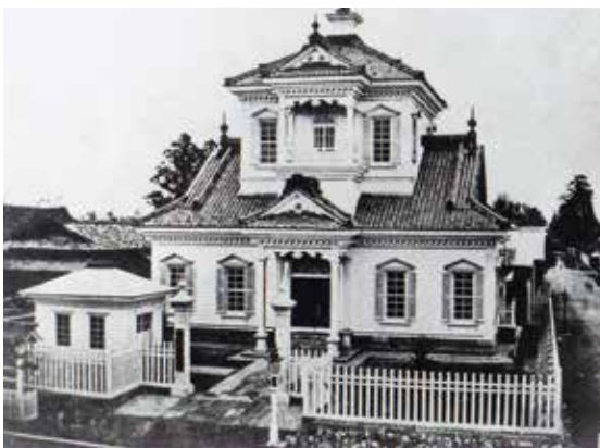
旧鶴岡警察署庁舎創建当時
