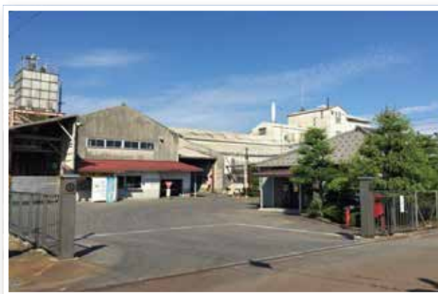
水沢工場様の外観
